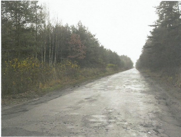
Rysunek nr 5 Nawierzchnia drogi powiatowej nr 4545E w km 2+100
