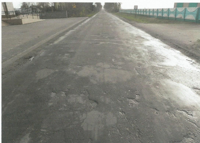
Rysunek nr 3 Nawierzchnia drogi powiatowej nr 4545E w km 0+270
