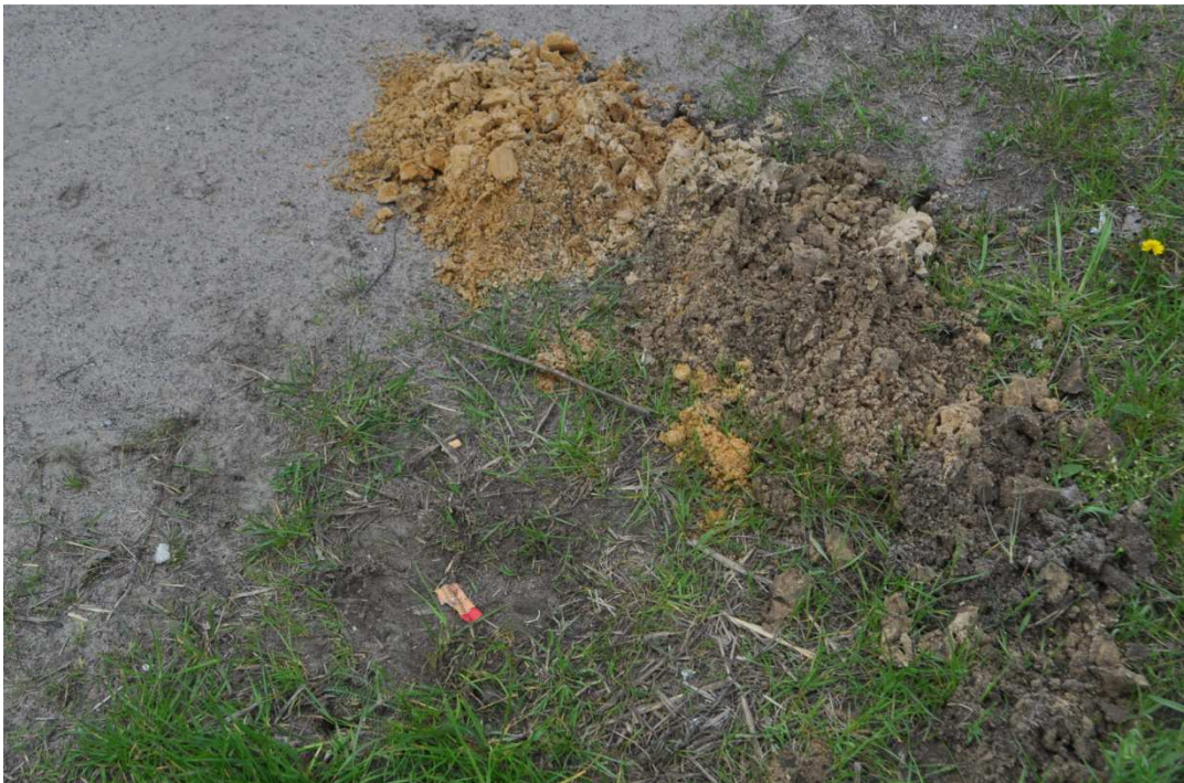
Wykonywanie odwiertów ul. Reymonta 25cm humus, 95cm piasek z czarną ziemią, 80cm piasek wzorcowy wody gruntowej nie nawiercono
