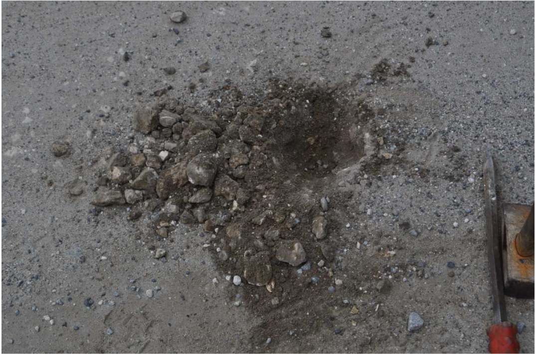
Wykonywanie odwiertów ul. Reymonta Odwiert w km 2+170 - 10,0cm kamień
