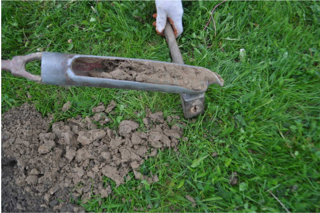
Wykonywanie odwiertów ul. Reymonta 60cm ziemia/nasyp budowlany, 55cm piasek gliniasty, 80cm glina
