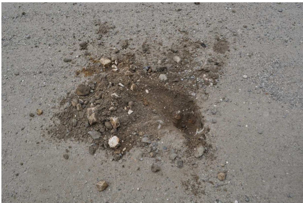
Wykonywanie odwiertów ul. Reymonta Odwiert w km 1+600 – 10cm tłuczeń
