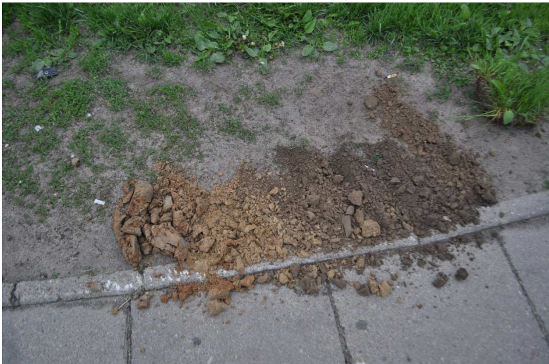
Wykonywanie odwiertów ul. Reymonta 83cm ziemia czarna, 30cm piasek gliniasty, 80cm glina
