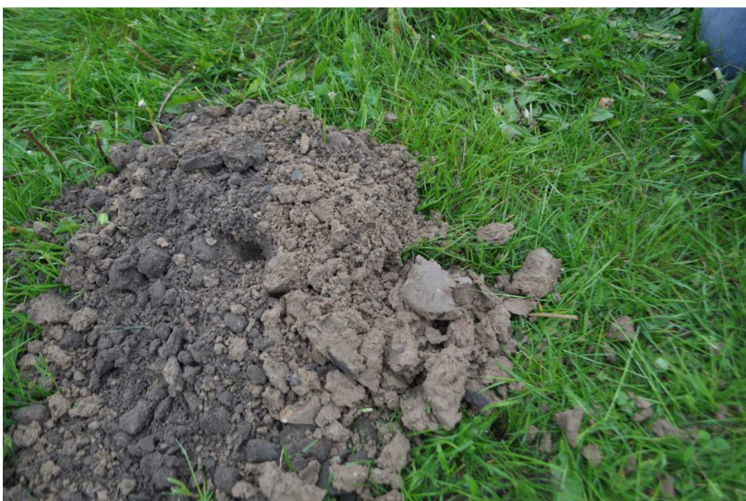
Wykonywanie odwiertów ul. Reymonta 60cm ziemia/nasyp budowlany, 55cm piasek gliniasty, 80cm glina
