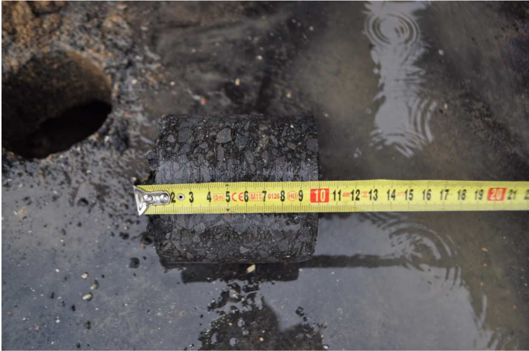
Wykonywanie odwiertów ul. Reymonta 10cm – warstwa bitumiczna
