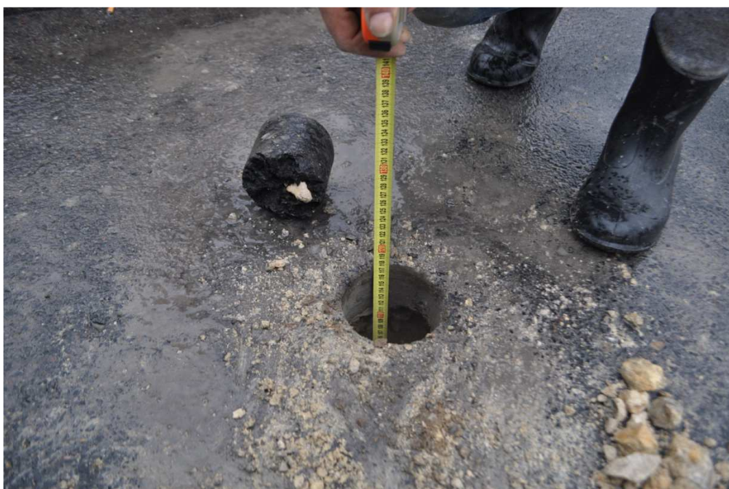
Wykonywanie odwiertów ul. Reymonta Odwiert na głębokość 120cm
