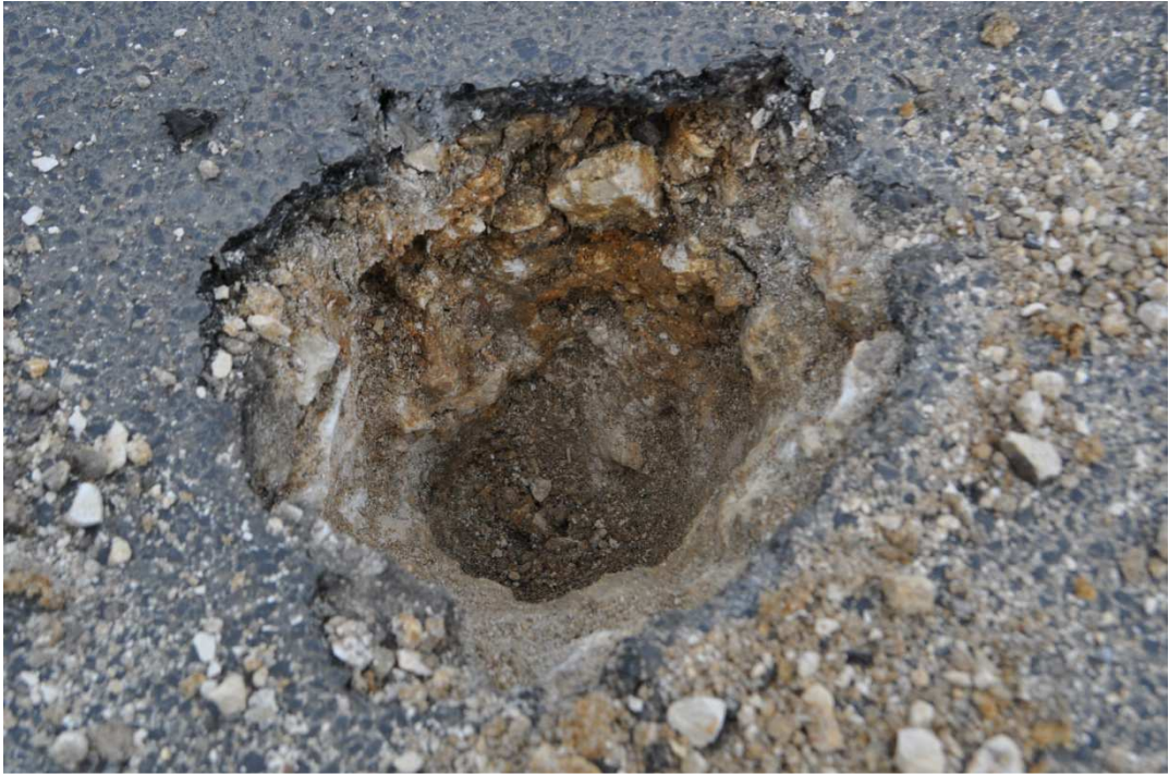
Wykonywanie odwiertów ul. Reymonta 1cm powierzchniowe utrwalenie 15cm kamień wapienny
