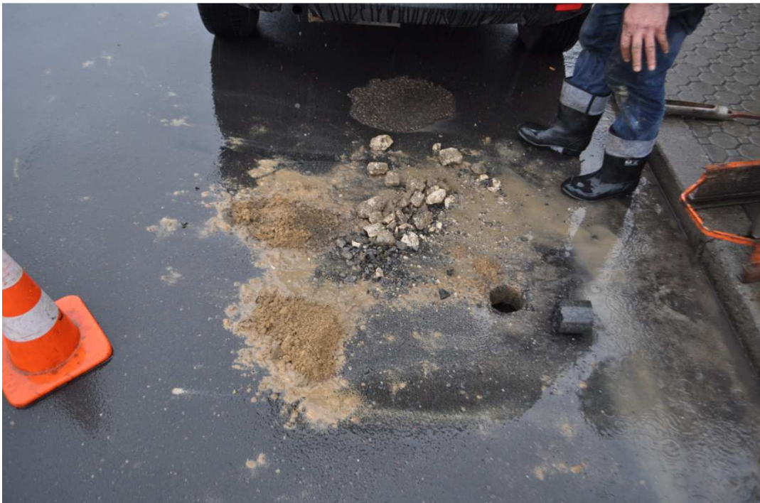
Wykonywanie odwiertów ul. Reymonta 10cm – warstwa bitumiczna, 40cm kruszywo wapienne, 130cm piasek barwy żółtej
