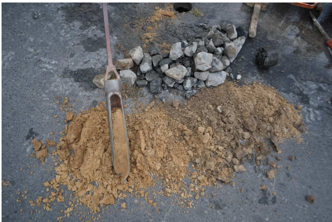
Wykonywanie odwiertów ul. Reymonta 32cm kruszywo, 40cm piasek barwy brunatnej, 100cm piasek barwy żółtej z domieszką gliny
