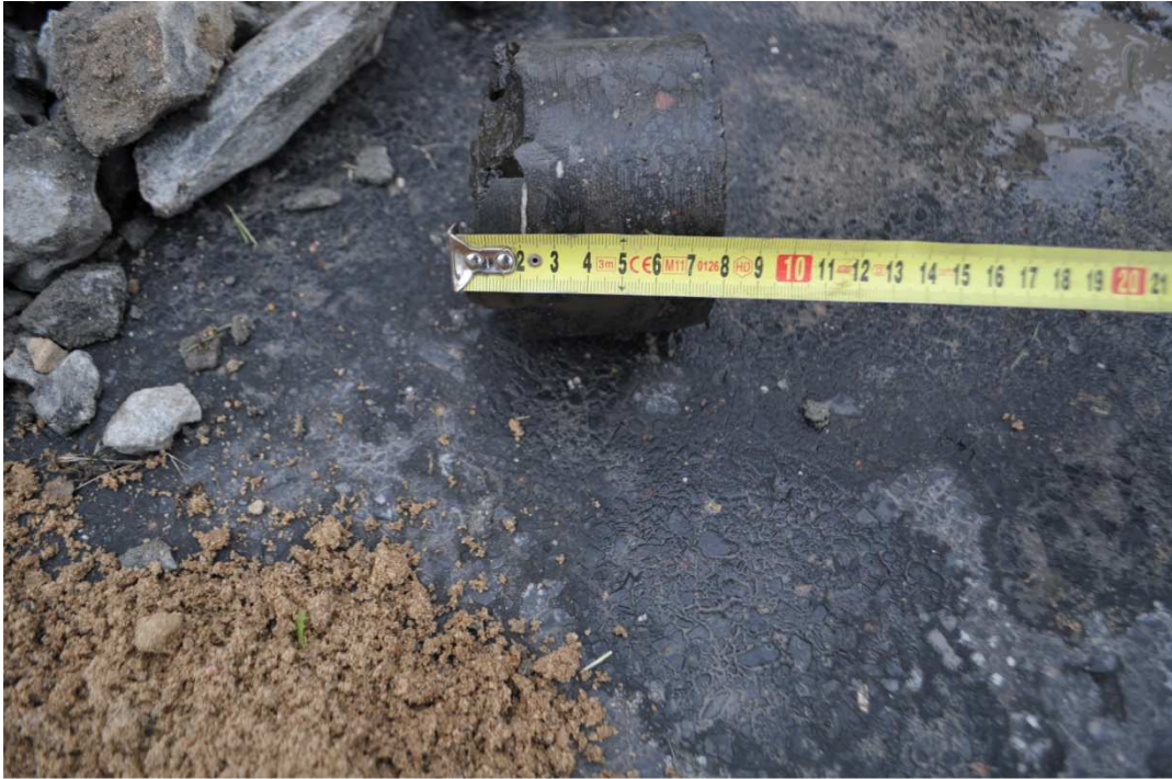
Wykonywanie odwiertów ul. Reymonta 8cm – warstwa bitumiczna
