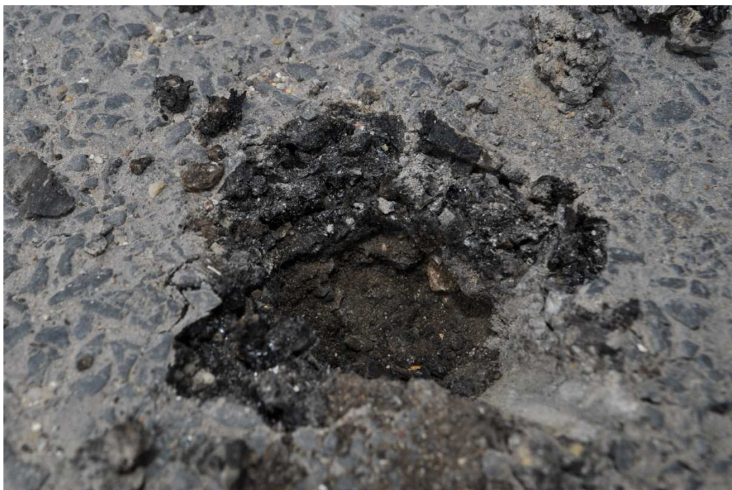
Wykonywanie odwiertów ul. Reymonta 2÷3cm powierzchniowe utrwalenie 8,5÷10cm kamień
