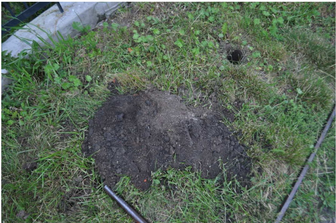
Wykonywanie odwiertów ul. Reymonta 5cm darnina, 195cm nasyp budowlany/gruz
