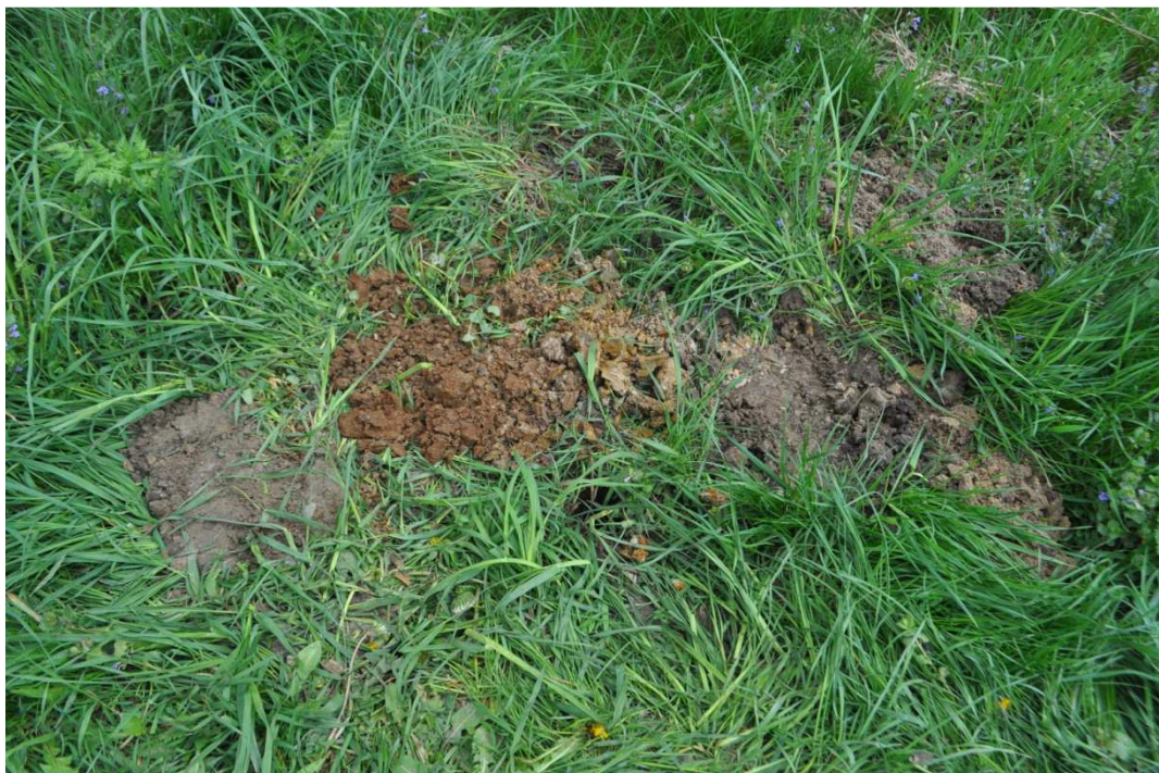
Wykonywanie odwiertów ul. Reymonta Odwiert w km 1+600 – w poboczu
