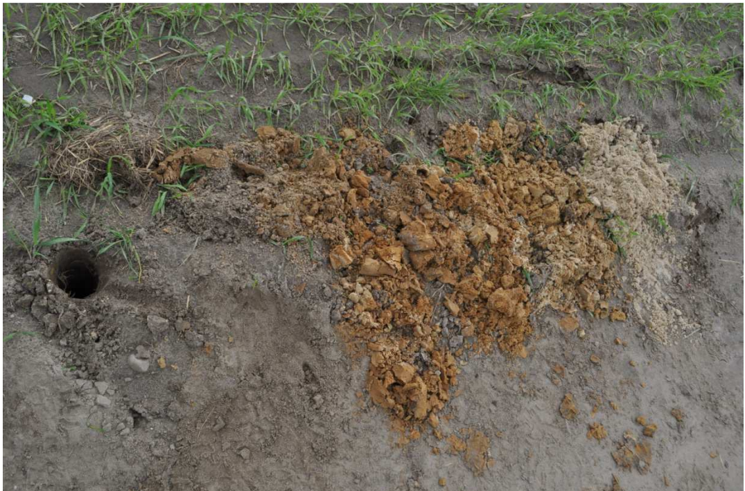
Wykonywanie odwiertów ul. Reymonta Odwiert w km 2+200
