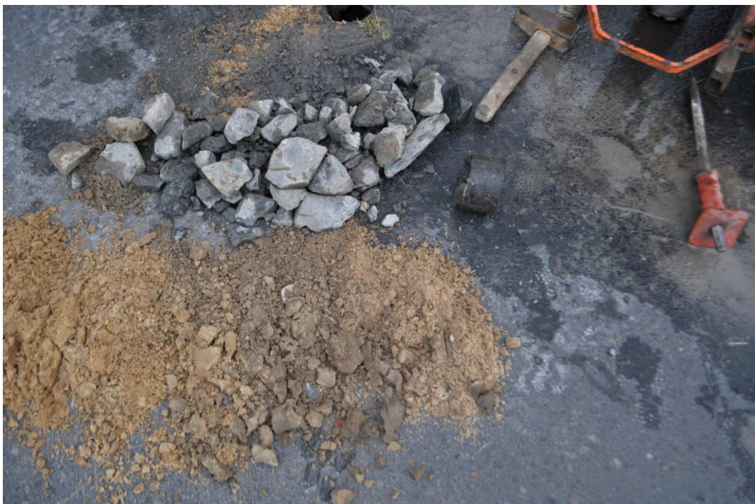
Wykonywanie odwiertów ul. Reymonta 32cm kruszywo, 40cm piasek barwy brunatnej, 100cm piasek barwy żółtej
