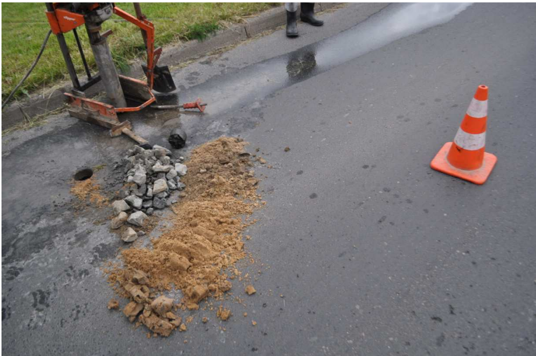
Wykonywanie odwiertów ul. Reymonta Odwiert nr 1 km 0+026
