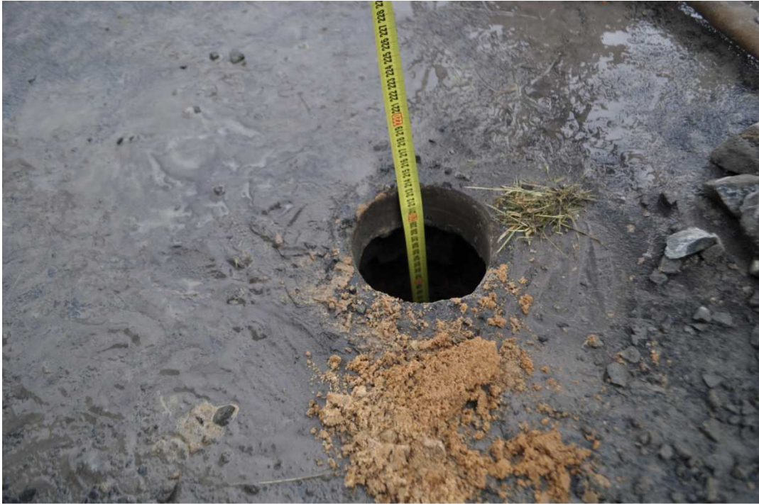
Wykonywanie odwiertów ul. Reymonta Odwiert na głębokość 210cm
