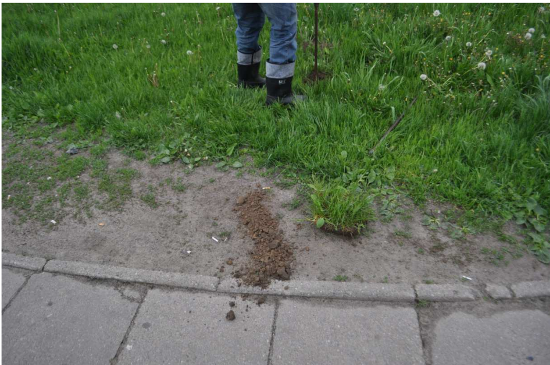
Wykonywanie odwiertów ul. Reymonta Odwiert w km 0+002 za chodnikiem str. L
