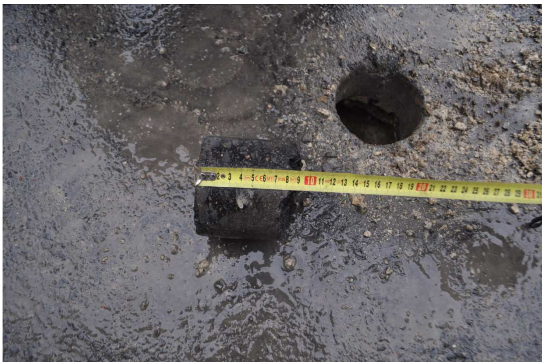
Wykonywanie odwiertów ul. Reymonta 9cm – warstwa bitumiczna
