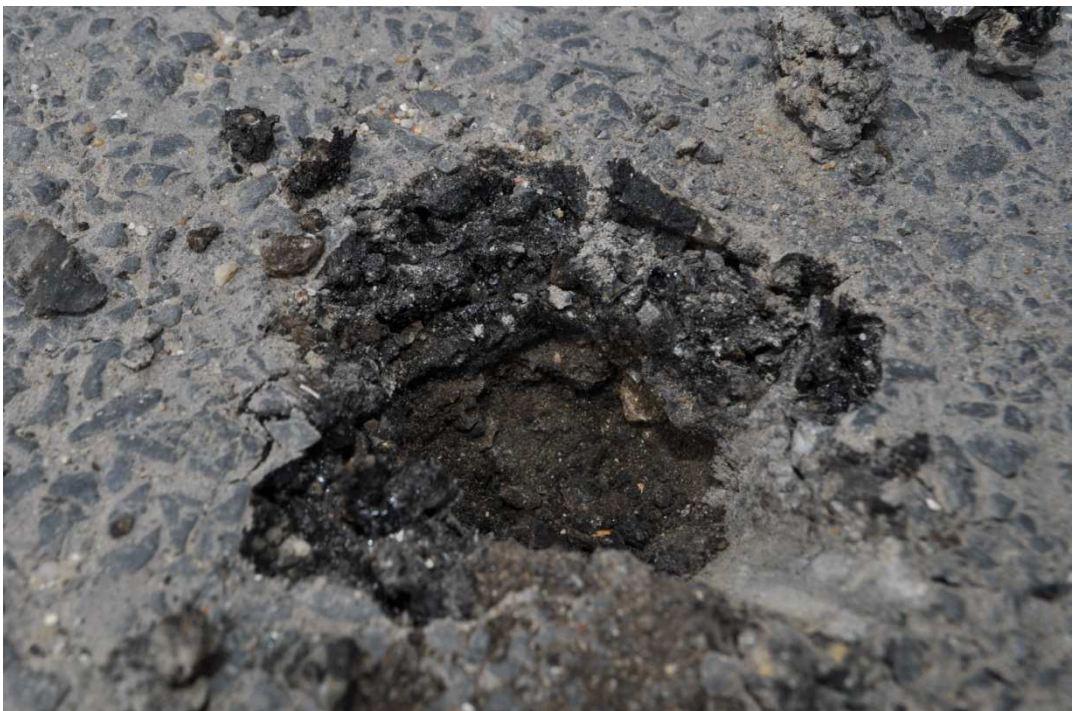
Wykonywanie odwiertów ul. Reymonta Odwiert w km 1+520
