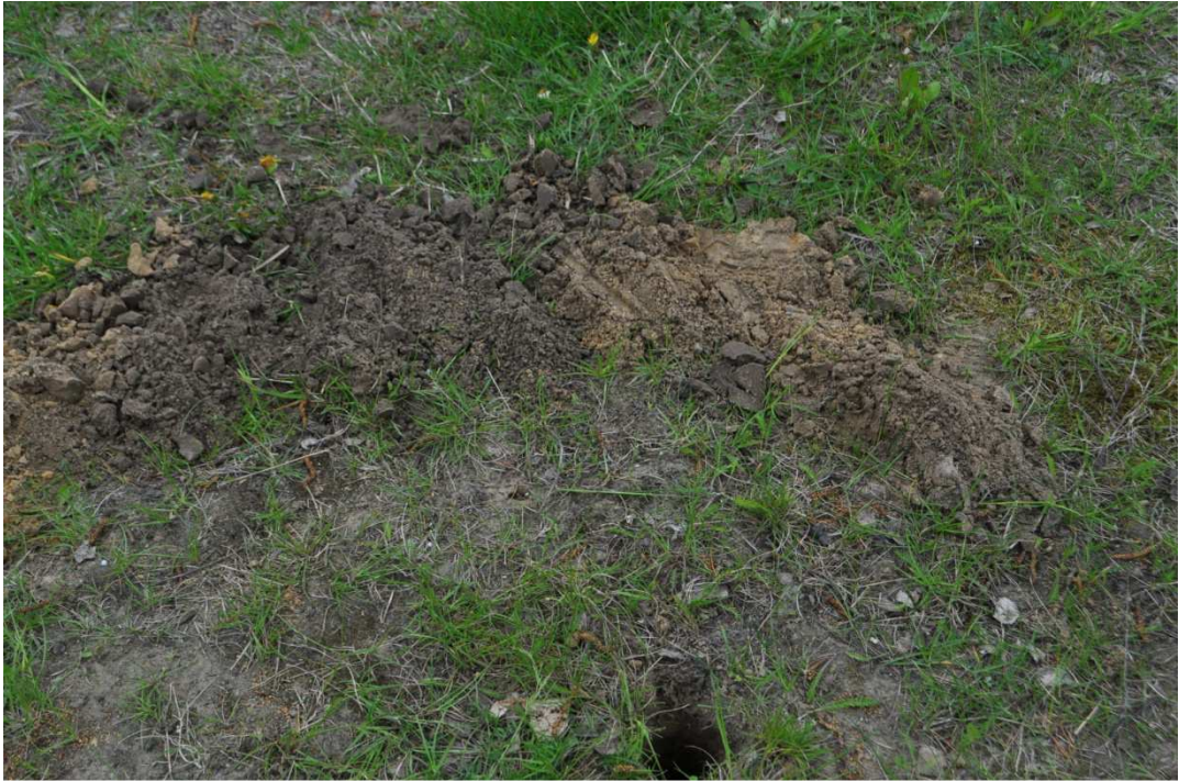
Wykonywanie odwiertów ul. Reymonta Odwiert w km 0+600
