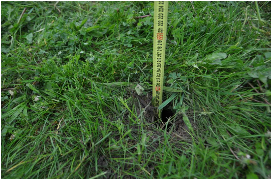
Wykonywanie odwiertów ul. Reymonta Odwiert na głębokość 200cm
