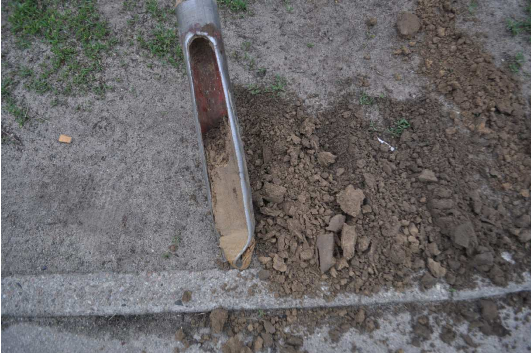
Wykonywanie odwiertów ul. Reymonta 83cm ziemia czarna
