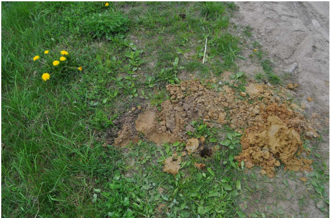
Wykonywanie odwiertów ul. Reymonta Odwiert w km 3+150
