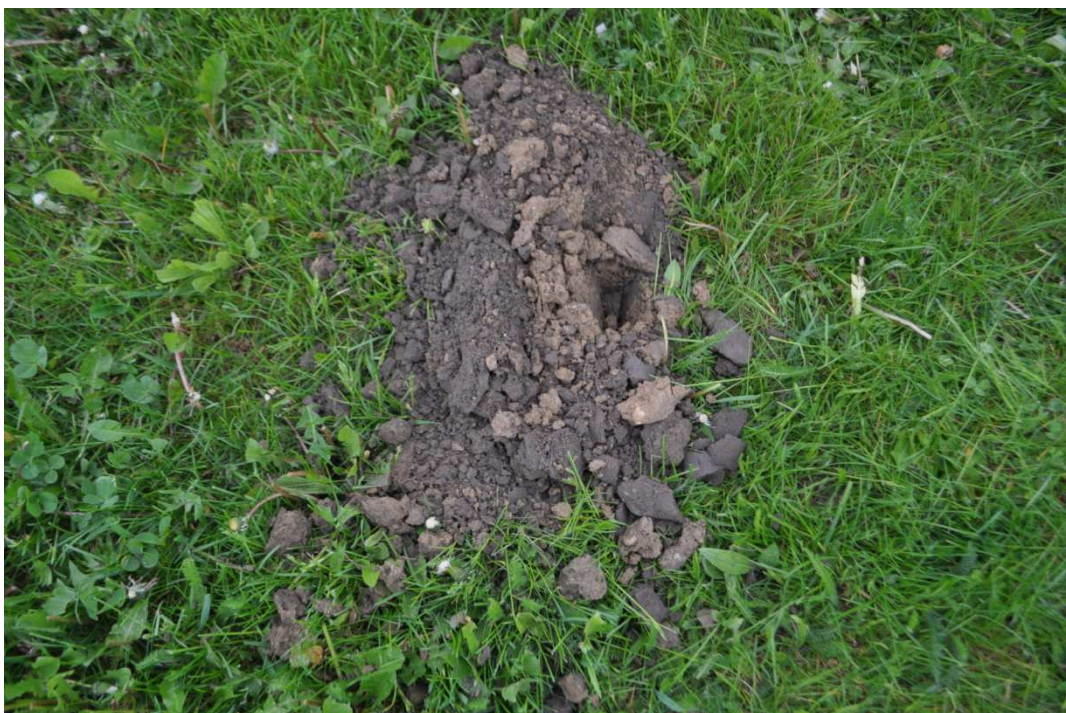
Wykonywanie odwiertów ul. Reymonta 60cm ziemia/nasyp budowlany
