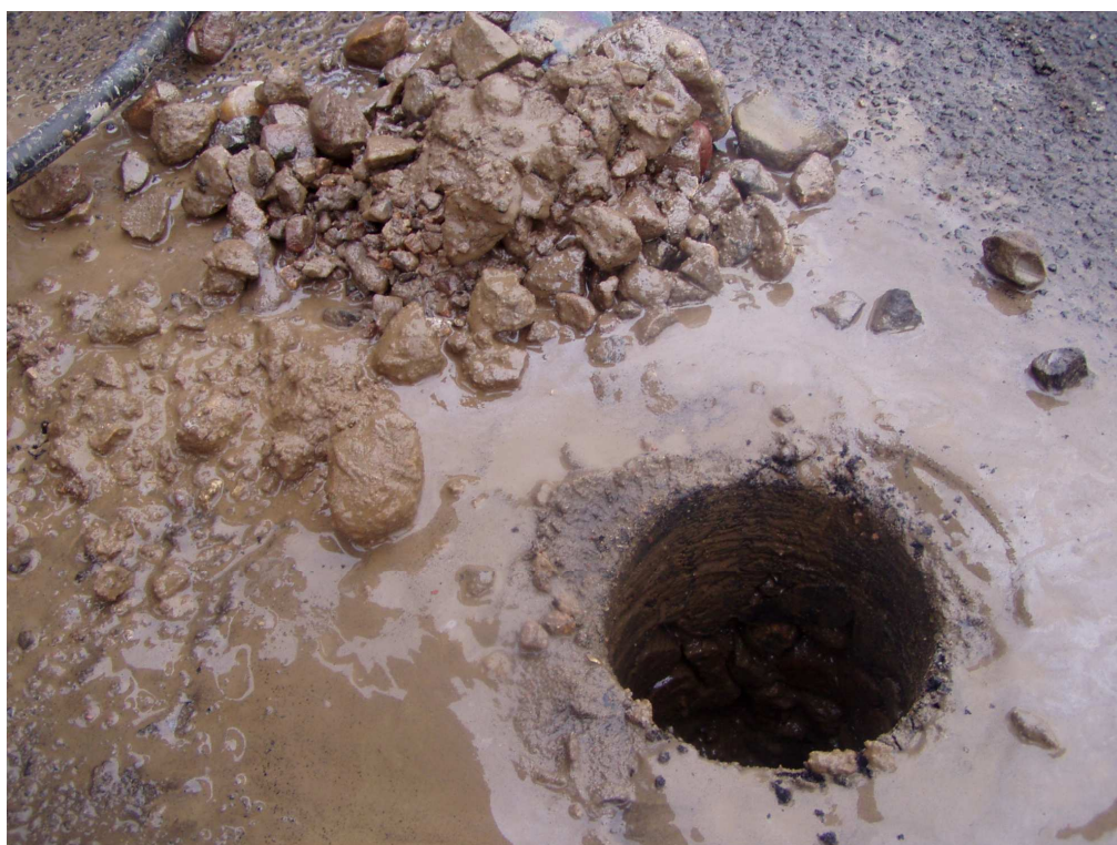
Km 6+000 podbudowa z tłucznia kamiennego gr. 32cm
